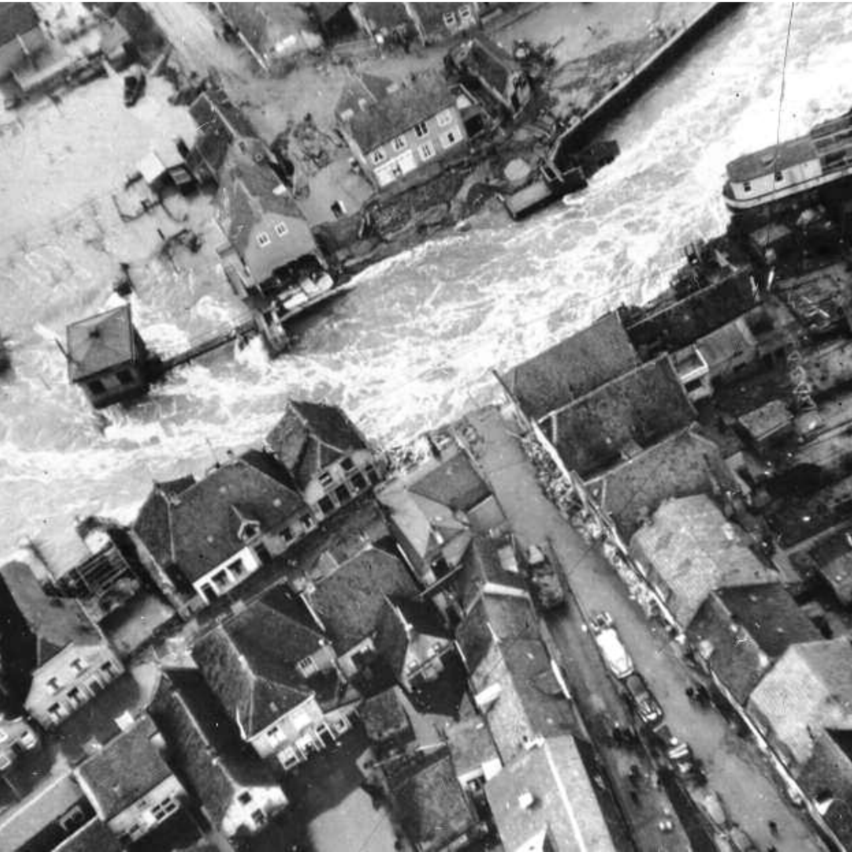
Het stroomgat in De Bommel op Goeree-Overflakkee.
